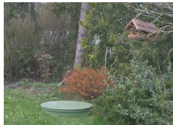
ČOV TOPAS S 5 po instalaci
